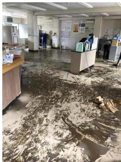
浸水被害を受けた宮城県内の農協支店
